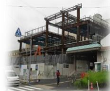
改良工事中の芦屋駅
