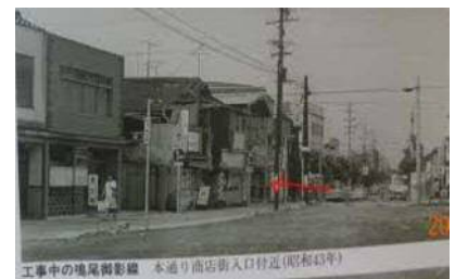
工事中の鳴尾御影線（昭和 43 年）
