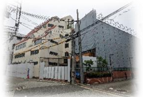
工事中の建物
